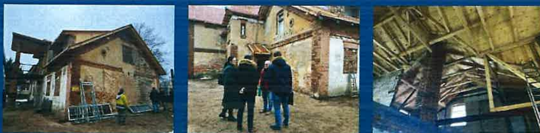
Pałacyk w Źródniku - stan prac w lutym 2023 r.
